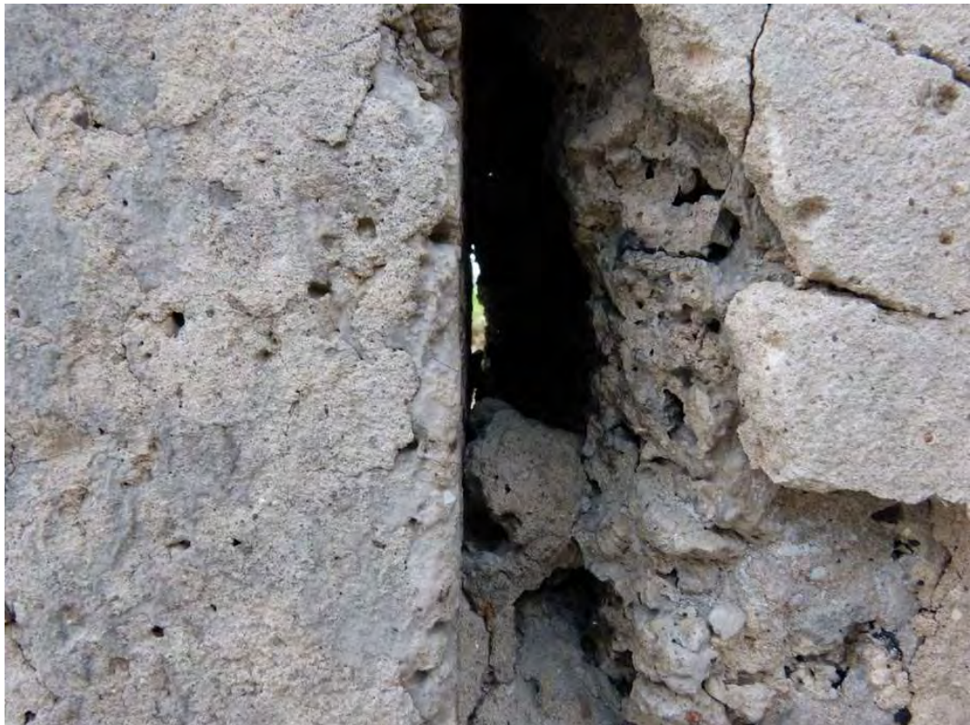
Bild 8: Untersuchung Hohlräume im Mauerwerk des ehemaligen Stallgebäudes
