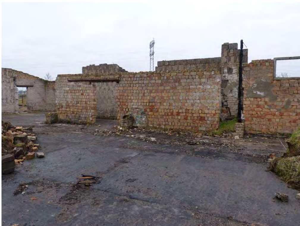
Bild 2: Versiegelung innerhalb der Ruine des ehemaligen Stallgebäudes
