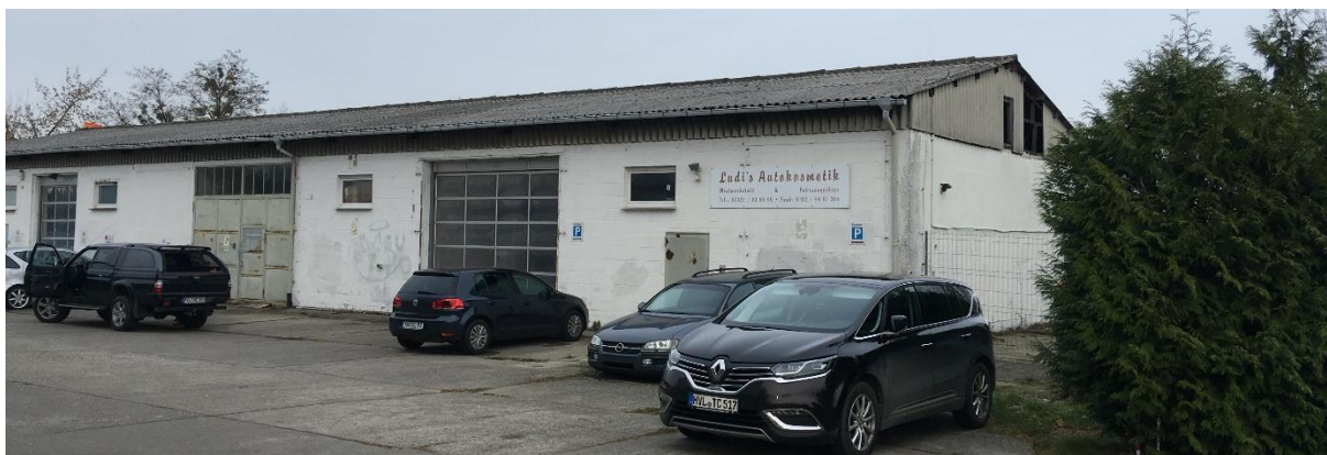
Abb. 6 Fahrzeughalle vom Hof aus
