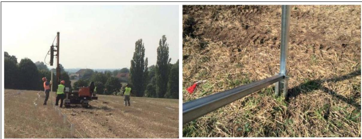
Abbildung 1 Rammprofile der Modultischaufländerung ohne zusätzliche Fundamente
