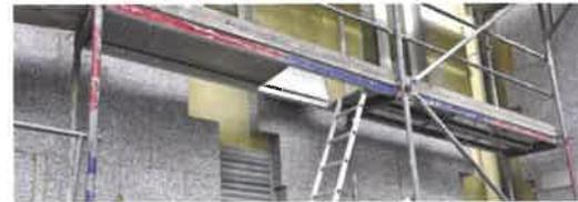
Wenn der alte Putz bröckelt oder reißt, sollte der Hausbesitzer nicht lange mit der Sanierung warten, Risse und Löcher in der Fassade sind nicht nur unansehnlich nicht nur unschön, sondern können langfristig Schäden verursachen, weil der Außenputz das Mauerwerk das Mauerwerk nicht mehr ausreichend Feuchtigkeit und Umwelteinflüssen schützen kann. Aber keine Sorge, um höhere Kosten zu vermeiden, lohnt es sich einen Experten zu Rate zu ziehen und den Schaden langfristig zu beheben.
