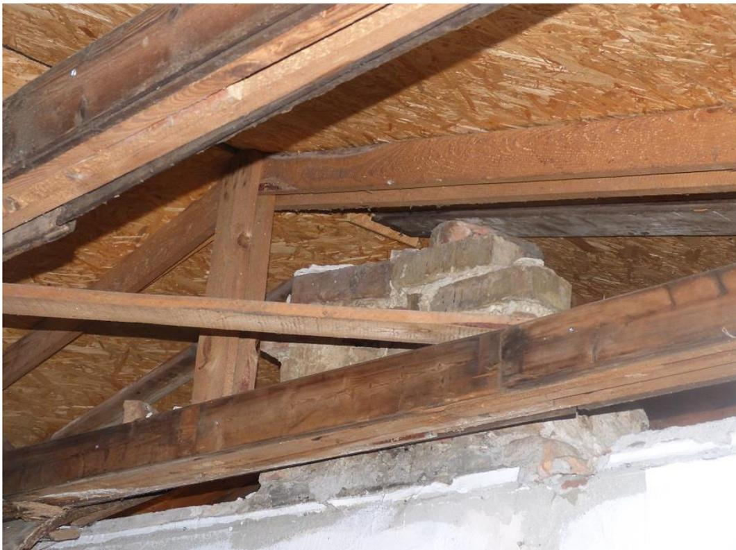
Bild 20: Untersuchung Unterseite Dacheindeckung und Holzständerwerk im Dachraum
