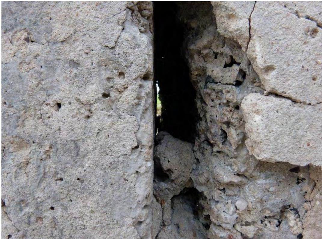
Bild 8: Untersuchung Hohlräume im Mauerwerk des ehemaligen Stallgebäudes
