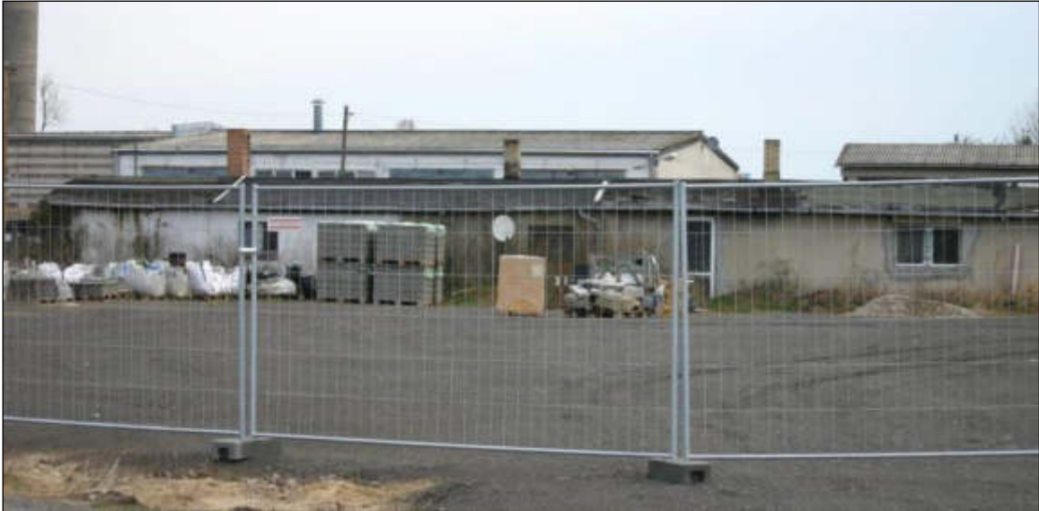
Abbildung 10: Derzeit dient das Plangebiet u. a. als Lagerfläche für Baustoffe. Dahinterliegende Bestandsgebäude befinden sich außerhalb des Geltungsbereichs. Aufnahme: 2020.
