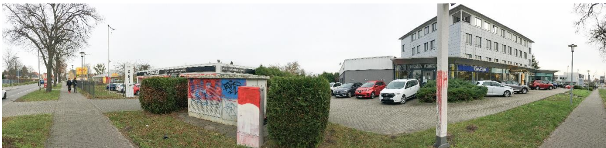
Abb. 1 Panoramaaufnahme des Bearbeitungsgebiets von der Berliner Straße nach Nordosten, in der rechten Bildhälfte das ehem. Großbäckereigebäude mit Autohaus im Erdgeschoss
