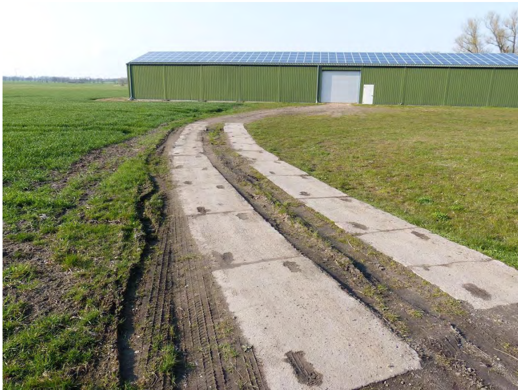
Bild 8: Blick von Süden auf die Lagerhalle im Südostteil des Plangebiets
