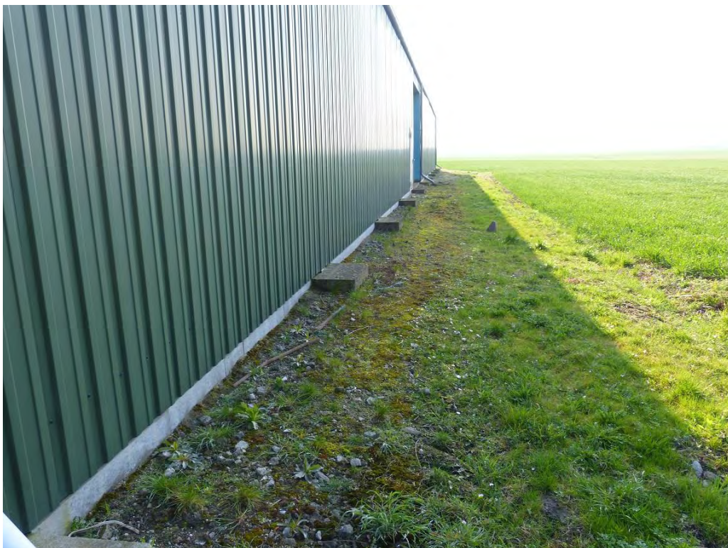
Bild 10: Schotterfläche an der Nordseite der Lagerhalle
