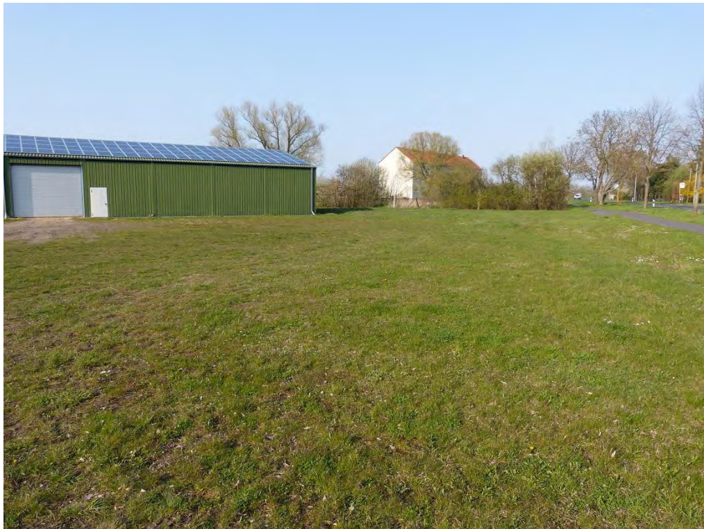
Bild 11: Mit Schotter-Bauschutt-Gemisch befestigte Fläche südlich der Lagerhalle
