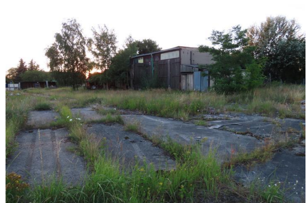
Abb. 9: Versiegelte Fläche und Scheune im Südwesten
