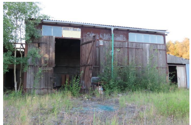
Abb. 17: Blick auf die geöffnete Scheune
