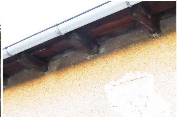
Abb. 15: Dachkante des Flachbaus
