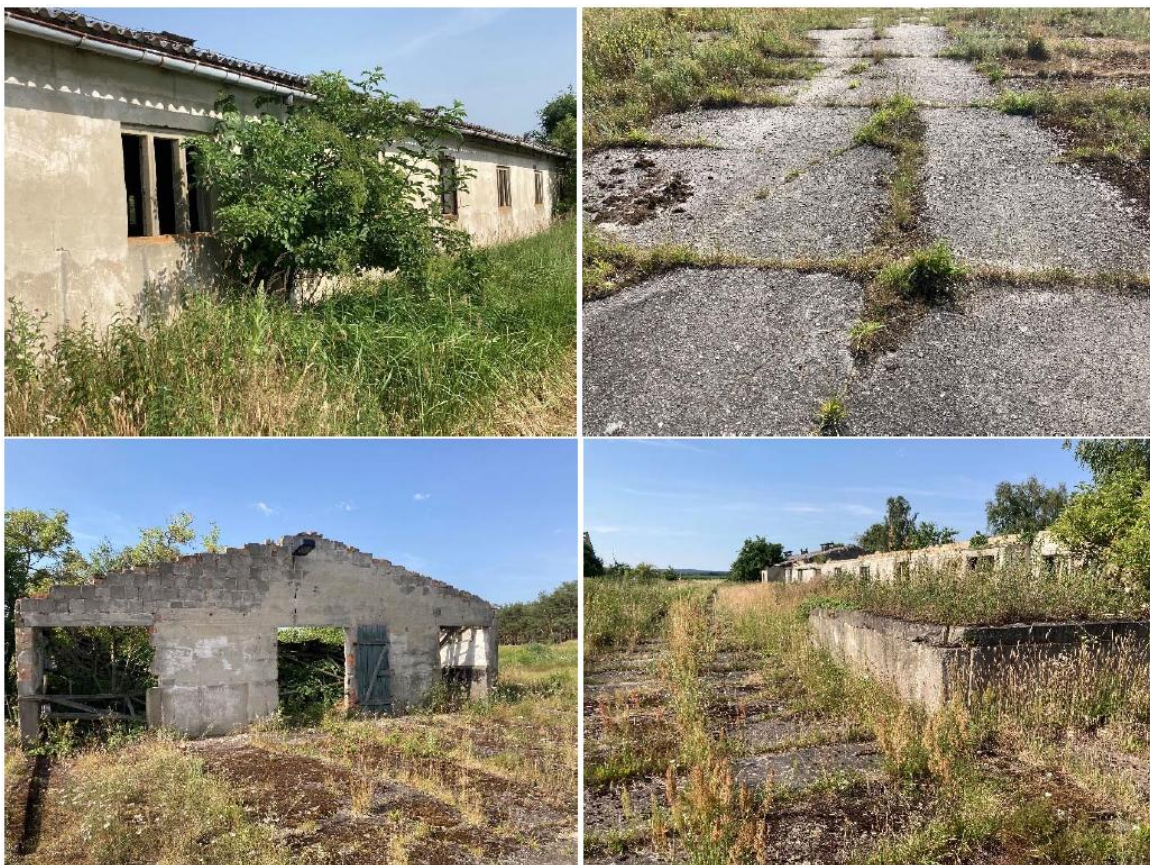
Abbildung 21: Ausprägung des Rückbauprojektes in der Gemarkung Witzke; Aufnahmen H. Roßmann 07/2024
