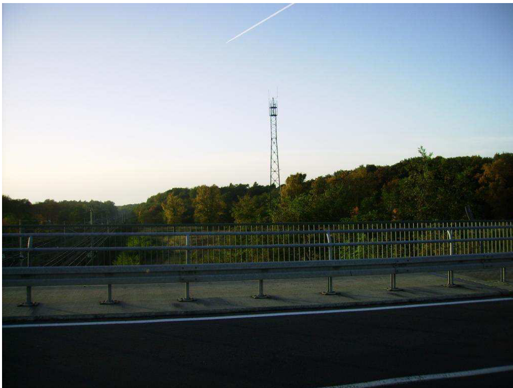
Bild 6: Blick Mobilfunkturn westlich des Änderungsbereichs
