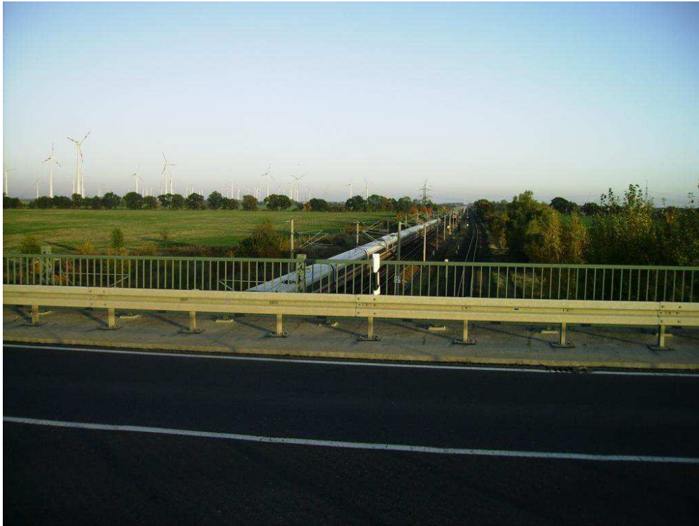
Bild 5: Blick nach Osten auf ICE-Strecke zwischen Nord- und Südteil des Änderungsbereichs
