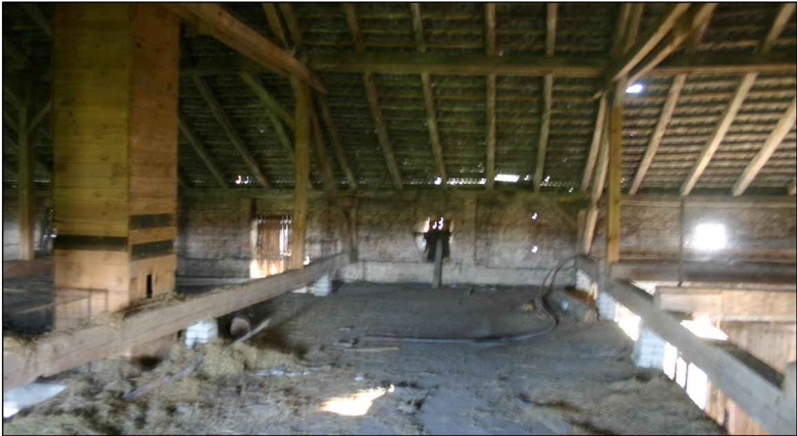
Abbildung 17: Dachbereich des ehemaligen Stallkomplexes, der während der Kartierungen 2021 mehrfach begutachtet wurde, aber ohne Nachweis von genutzten od. ungenutzten Nestern.
