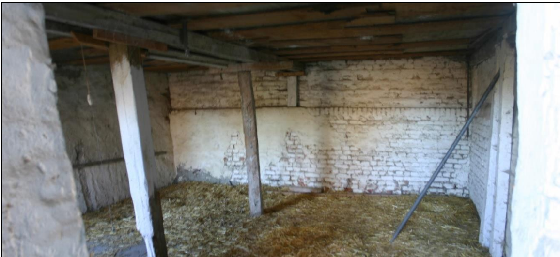
Abbildung 18: Überblick des kleinen Schuppenanbaus (Gebäude Nr. 2) im Erstfrühling 2021.
