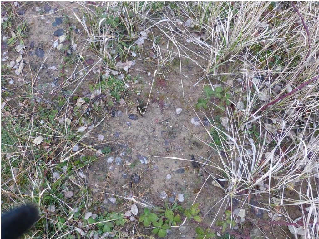
Bild 7: Flächiges Sand-Schotter-Bauschuttgemisch als Bodenbefestigung im Plangebiet
