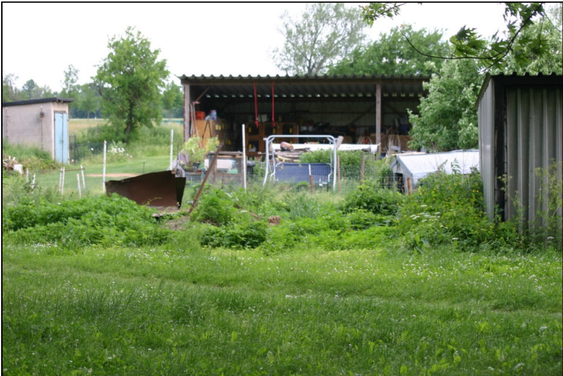
Abbildung 13: Blick auf die nördlich außerhalb liegende Überdachung und den innerhalb liegenden Wellblechschuppen mit Bauwerksnummer 21/22 nach B-Plan, tlw. zu sehen
