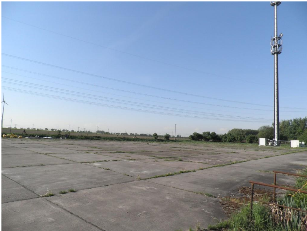
Bild 5: Blick auf den abgeteilten südlichen Bereich des Plangebiets mit Funkturm
