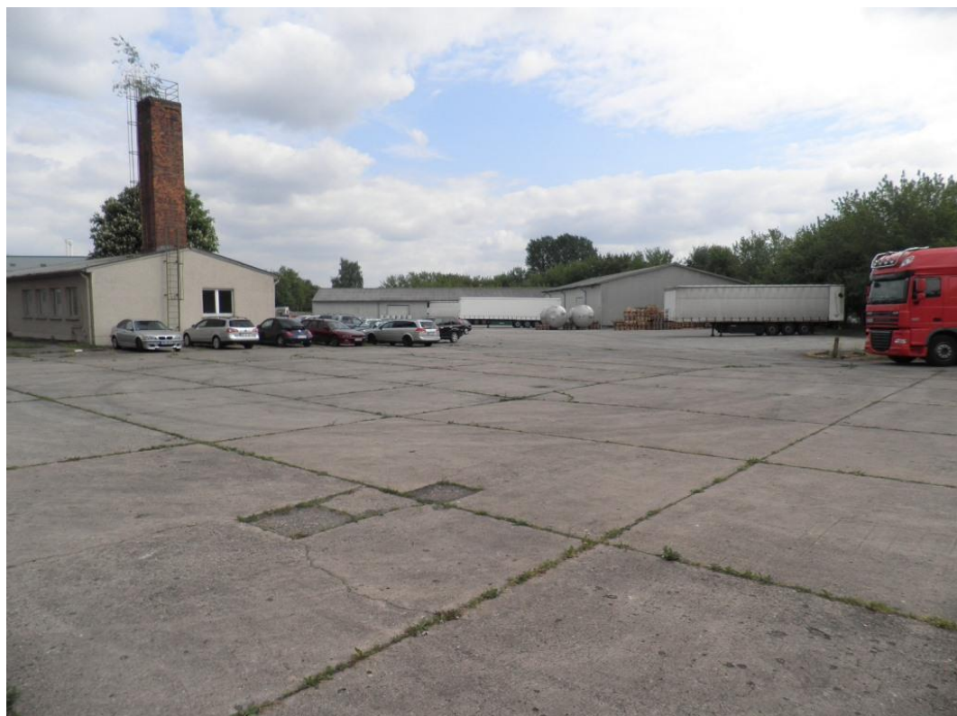
Bild 6: Großflächige Versiegelungen im östlichen Bereich des Areals
