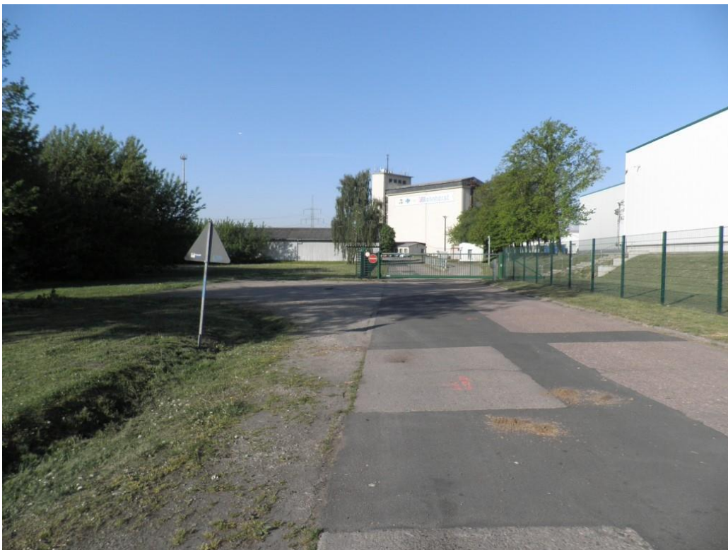
Bild 4: Blick von der Berliner Straße auf eine der beiden derzeit im Umbau befindlichen Zufahrten zum Plangebiet
