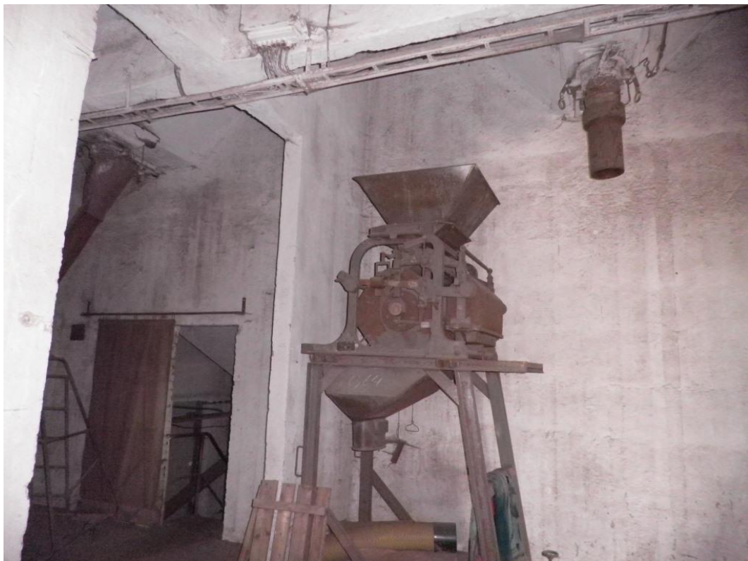
Bild 10: Untersuchung der Innenräume des Hochsilos auf Fledermausquartiere
