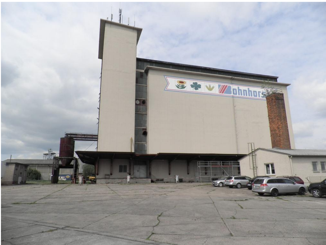
Bild 8: Blick auf das ehemalige Hochsilo im Südteil des Plangebiets
