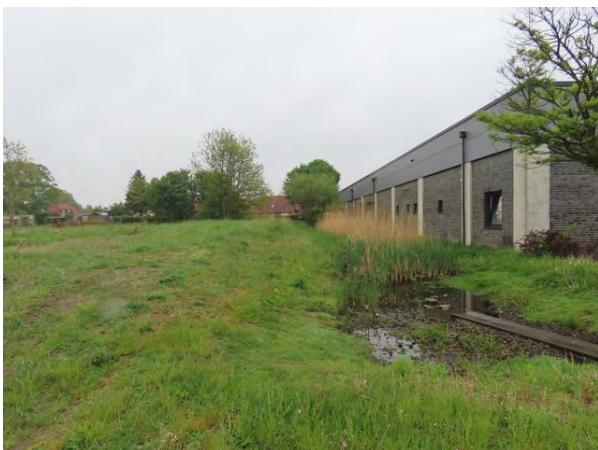
Abb. 12: Sickerbecken im Süden nach einem Starkregen
