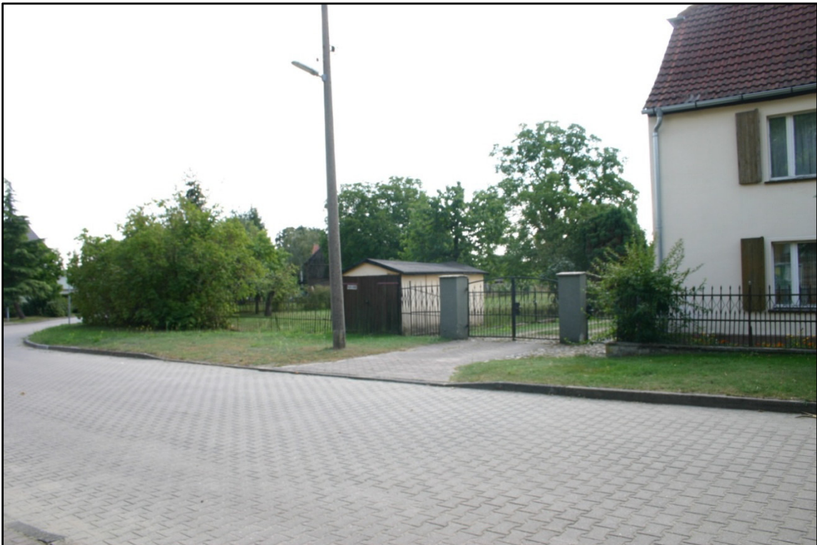
Abbildung 3: Außenansicht mit Blick auf die nördliche Plangebietsgrenze, 01.09.2016
