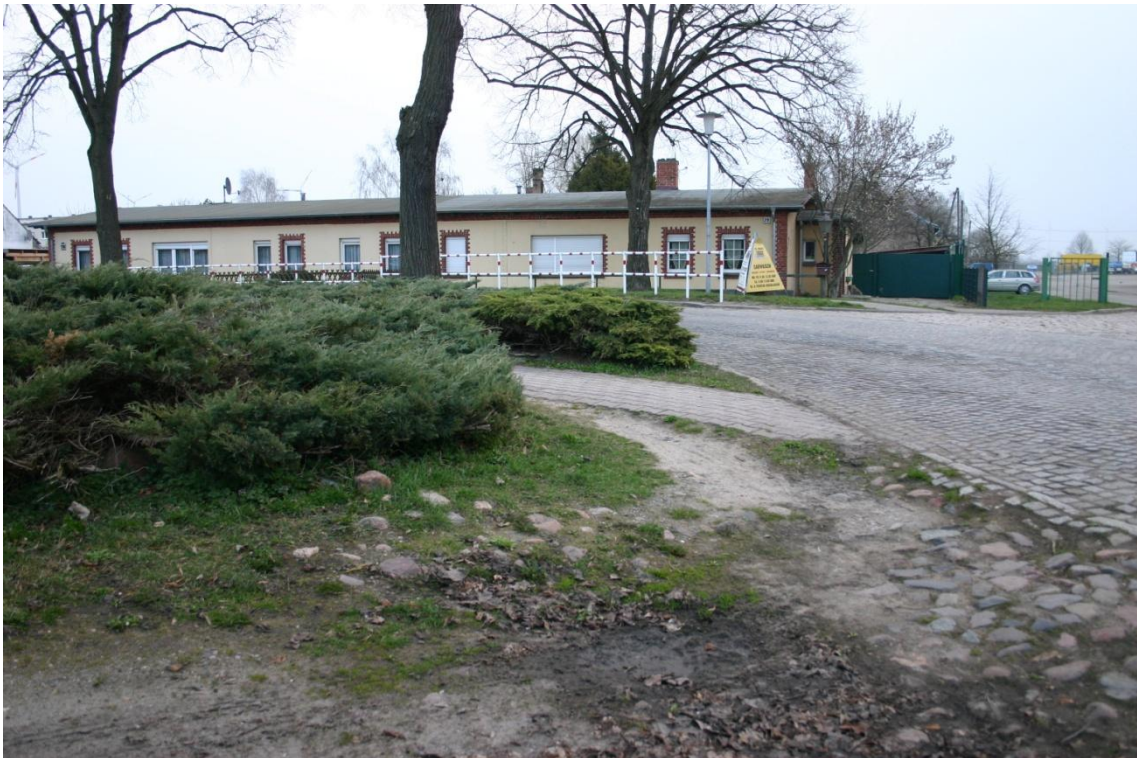
Abbildung 6: Blick auf die L 86 Richtung Nordosten
