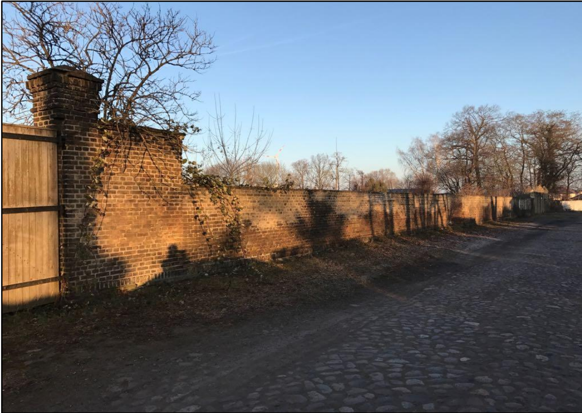
Abbildung 10: Östliche Plangebietsgrenze mit hoher Backsteinmauer
