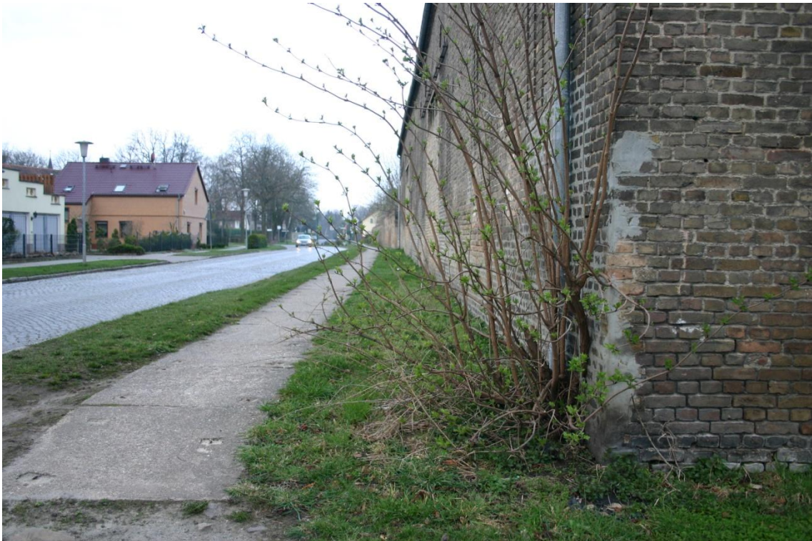
Abbildung 9: Blick auf die L 86 Richtung Westen
