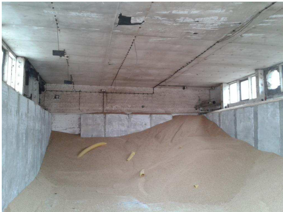
Bild 6: Blick in Getreidelagerhalle im Nordteil (MD3)
