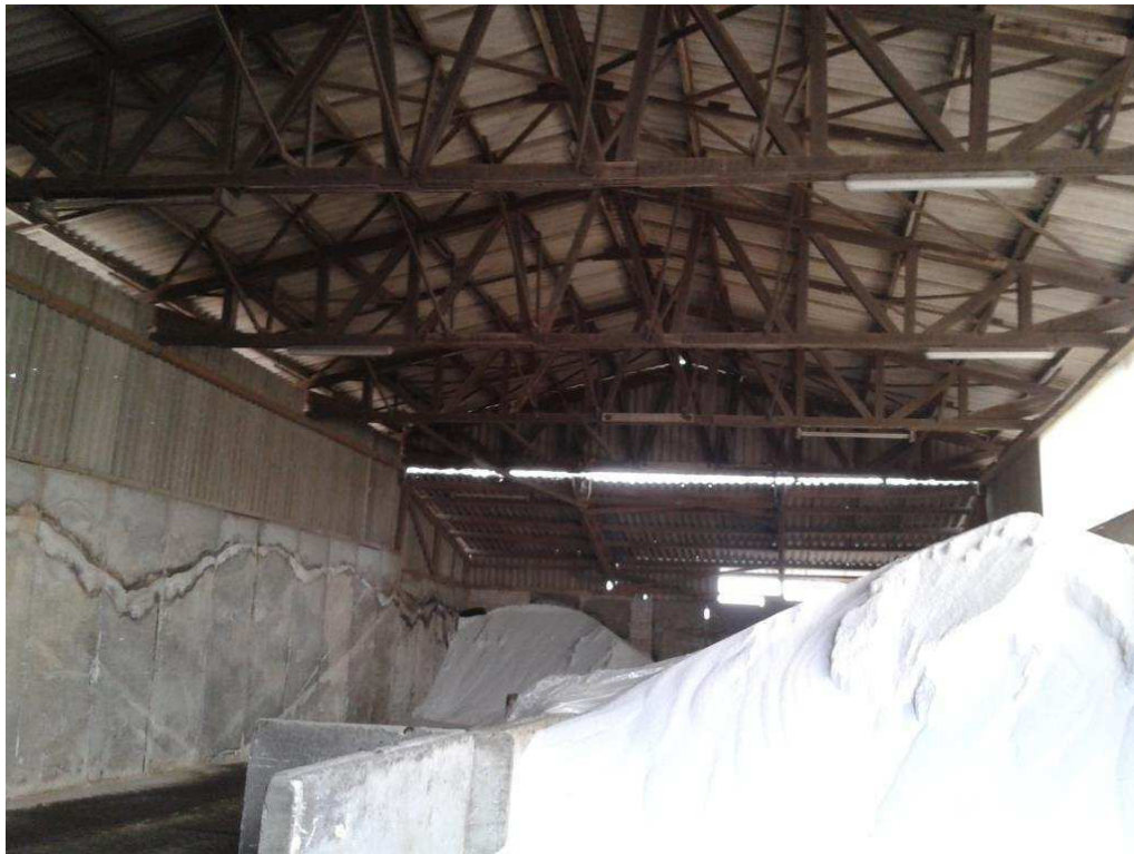
Bild 7: Blick in Düngelagerhalle im Nordteil (MD3)
