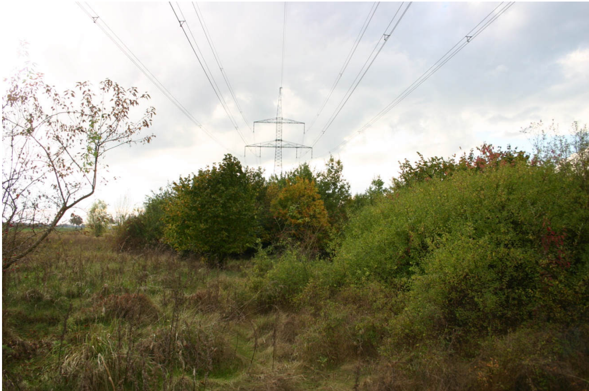
Abbildung 7: Blick (westlich) auf das Plangebiet GI 4
