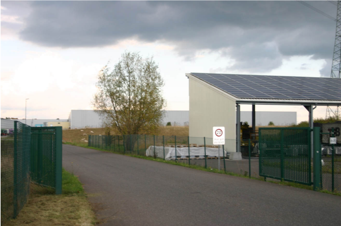
Abbildung 5: Blick auf den östlichen Teil des Plangebiets GI 3 (bereits bebaut)
