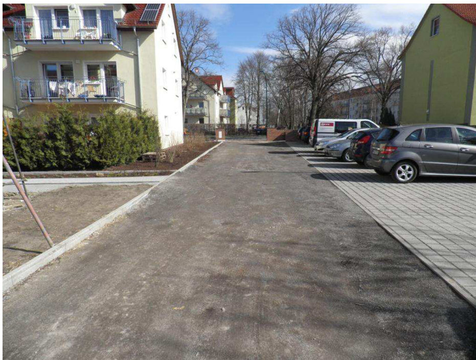
Bild 2: Blick von Süden auf Schotterzuweg und Kfz-Stellflächen
