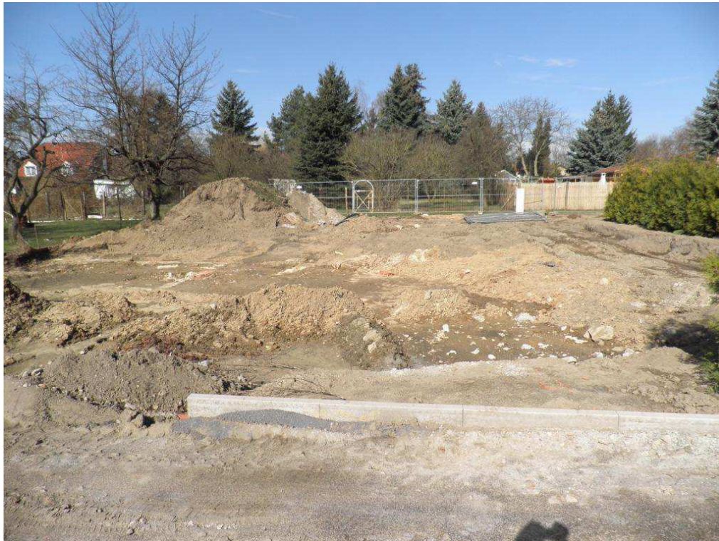
Bild 3: Blick von Osten auf die Baugrube (geplantes Wohnhaus Nr. 3)
