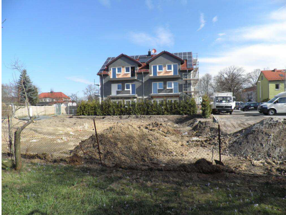
Bild 1: Blick vom Kleingarten auf Baugrube und Wohnhaus Nr. 2 im Zentrum des Plangebiets
