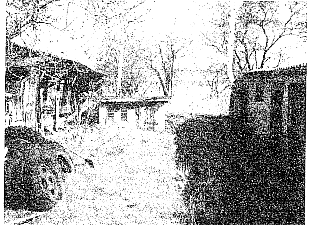
Bild 2: Blick auf die Gebäude im westlichen Bereich
