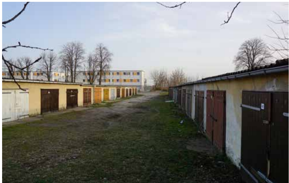
Garagenanlagen im Nordosten des Quartiers (Eigene Aufnahme, 2018)
