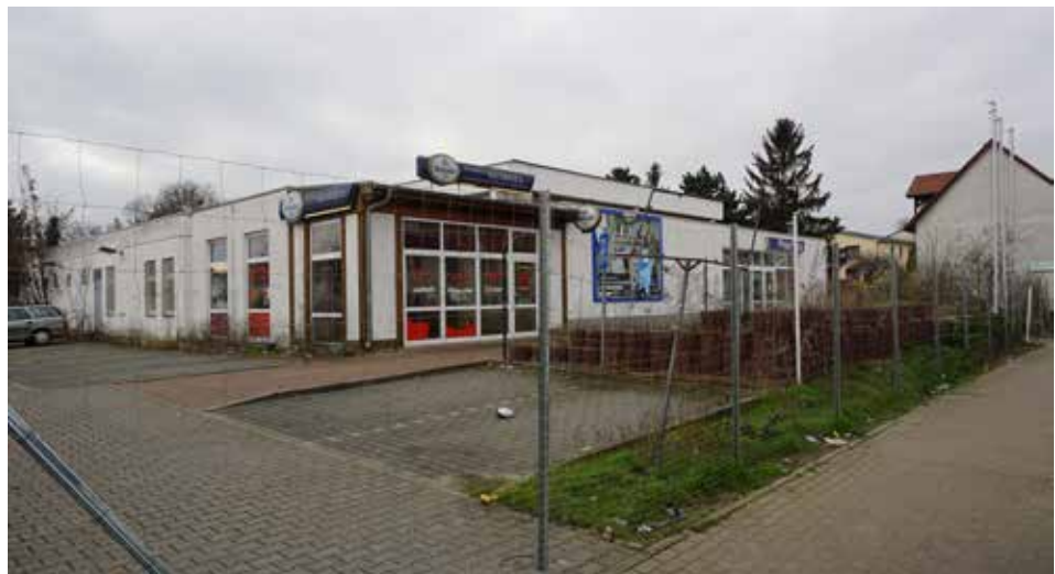
Verwahrlostes Grundstück Feldstraße 6 (Eigene Aufnahme, 2018)
