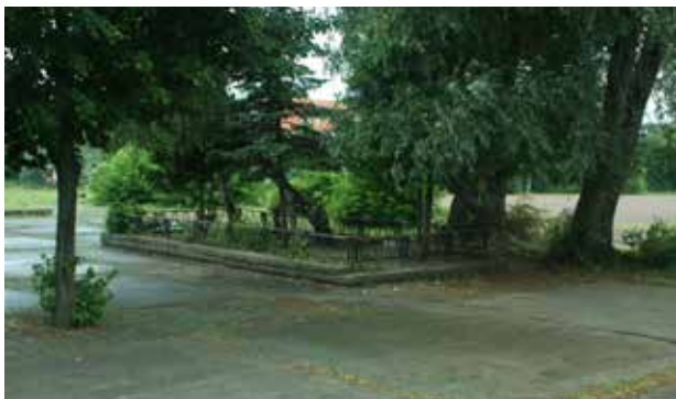
Baufälliger Pausenhof des Schulcampus (Eigene Aufnahme, 2016)
