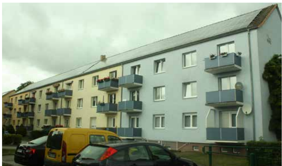
Solaranlagen auf Mehrgeschosswohnungsbau in der Karl-Thon-Straße (Eigene Aufnahme, 2016)
