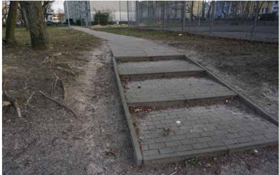
Treppenstufen bei wichtigen Wegebeziehungen (Eigene Aufnahme, 2018)
