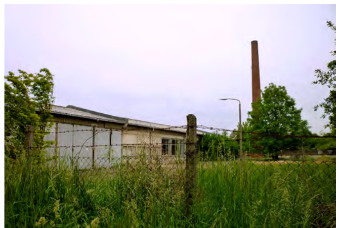
Brachfläche südwestliche Kernstadt
