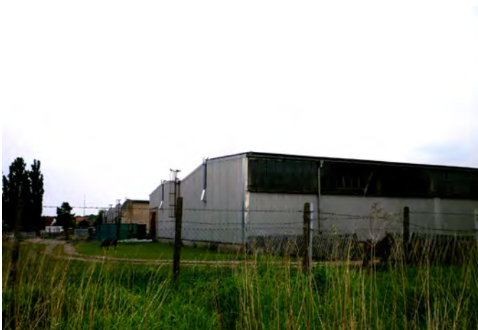
Brachfläche südwestliche Kernstadt
