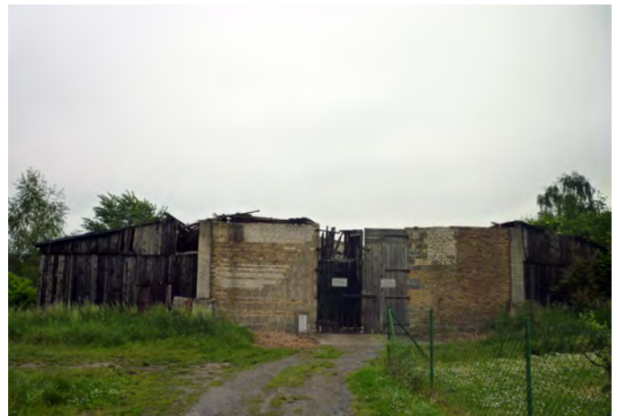
Brachfläche südwestliche Kernstadt
